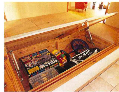
納戸では、床を上げた分を収納として利用。一輪車など大きい遊具を片付けられる部屋もある
