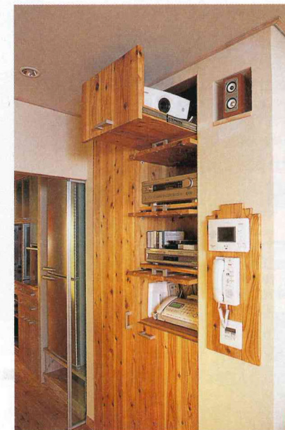
壁にキャビネットを設置。最上段にプロジェクターを置ける(トリアルルームの一例)
