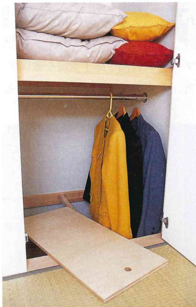
押し入れの下段も、羽目板を外せば衣服を収納できる工夫をこらしている
