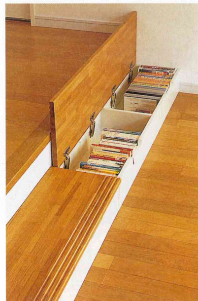
スラブを下げて天井高を確保したリビングでは、段差のある場所に床と同じデザインの収納ケースを置き、階段代わりにしている
